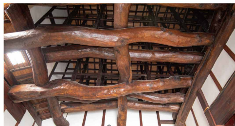
主屋土間の梁組
