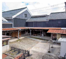
作業庭及び桶干場
